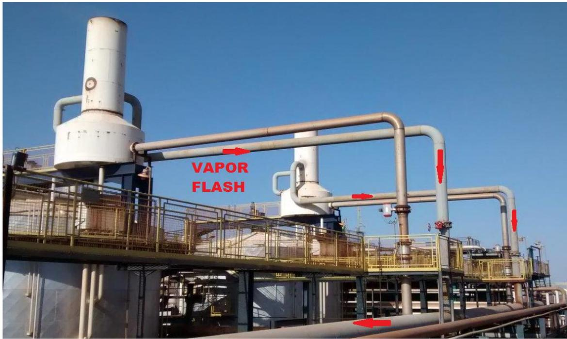
**VAPOR CONDUZIDO POR COLETOR ATÉ AQUECEDOR CASCO TUBO**
